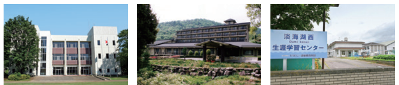
生涯学習センター(千葉県柏市) 中日本生涯学習センター(岐阜県瑞浪市) 淡海湖西生涯学習センター(滋賀県高島市)
